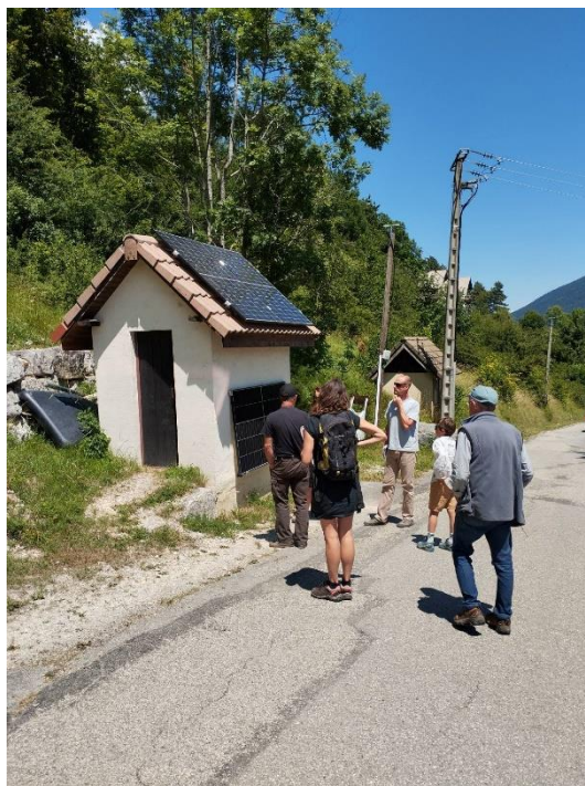
Figure 11 Visite de la pico-centrale hydraulique de St Andéol (crédit Franck Maurice-Laforge)
