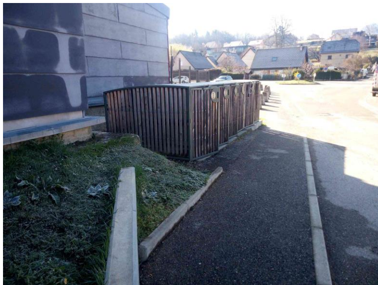
Figure 7 Garages à vélo à Mens (crédit photo Clotilde Senepin)
