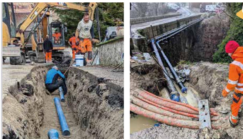
Figure 4 Chantier de remplacement de conduites d'eau potable (crédit Franck Maurice-Laforge)
